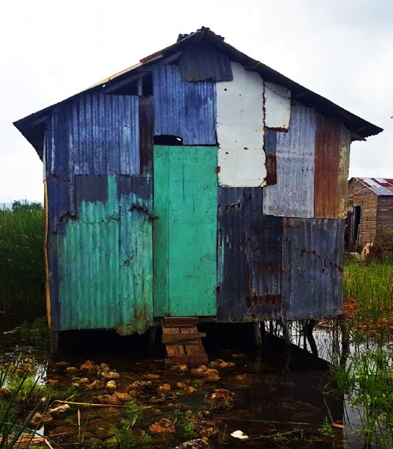
Vivienda característica del barrio Nueva York chiquito actualmente en proceso de secado del humedal con basura y caliche para la construcción de nuevas viviendas. Río San Juan, provincia María Trinidad Sánchez. Créditos: Fundación Destino
