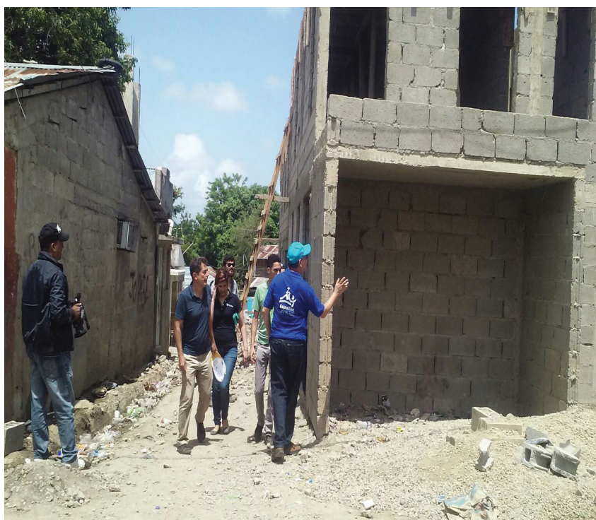
Ilustración 5: mejora de la accesibilidad al barrio Salsipuedes en Moca.
